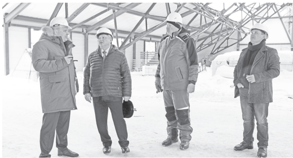
Виктор Казарин отметил, что строительные работы в Ледовом дворце значительно продвинулись вперёд. Фото: Анжела Белкина, ГТРК «Вектор».
