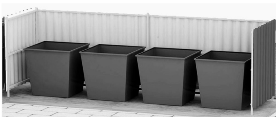
Внешний вид контейнерных площадок
